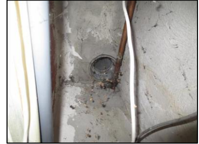
Photo N° 885 AMIANTE CIMENT -- PLACARDS GAZ +2 Gaines & coffres verticaux Ventilation haute (Fibres-ciment)
